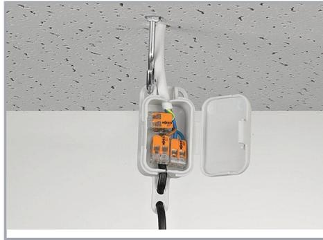
Anschluss von Pendelleuchten in abgehängten Decken
